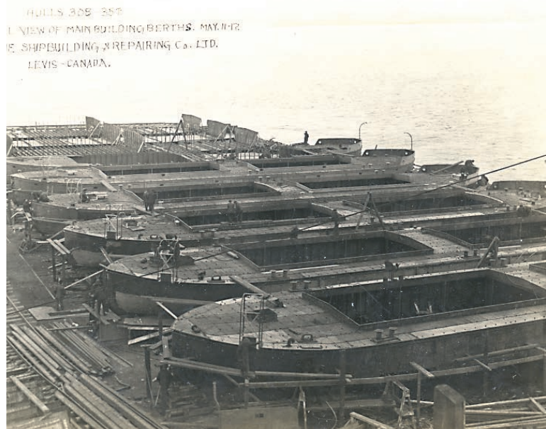
Navires de guerre au chantier Davie, en 1917 — PHOTO FOURNIE PAR LA SOCIÉTÉ D'HISTOIRE RÉGIONALE DE LÉVIS
